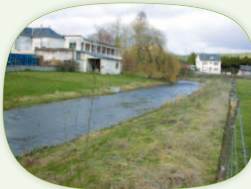
Après suppression du vannage et réaménagement du lit
