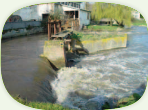
Vue du vannage avant l'aménagement
